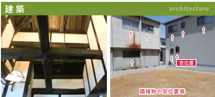
古民家など設計図のない 建物の現状把握
